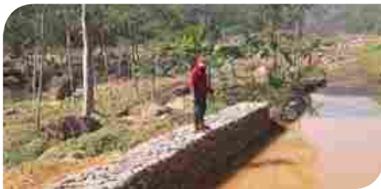
Pemasangan Batu Gabion di hulu area A oleh BPI
