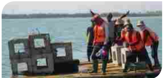
Pemasangan terumbu karang buatan
