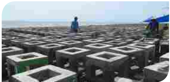
Konstruksi terumbu karang buatan
