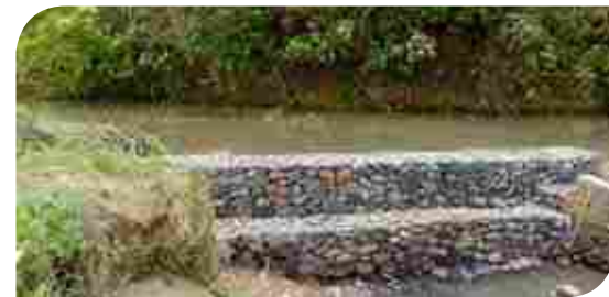
Pemasangan Batu Gabion di hulu area A oleh BPI
